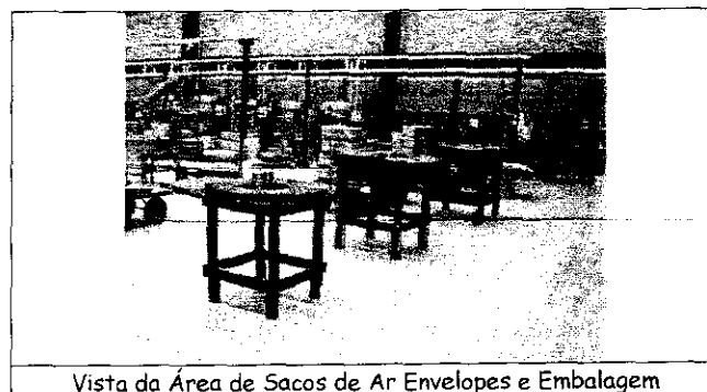
Vista da Área de Sacos de Ar Envelopes e Embalagem
