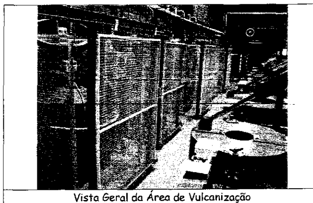
Vista Geral da Área de Vulcanização
